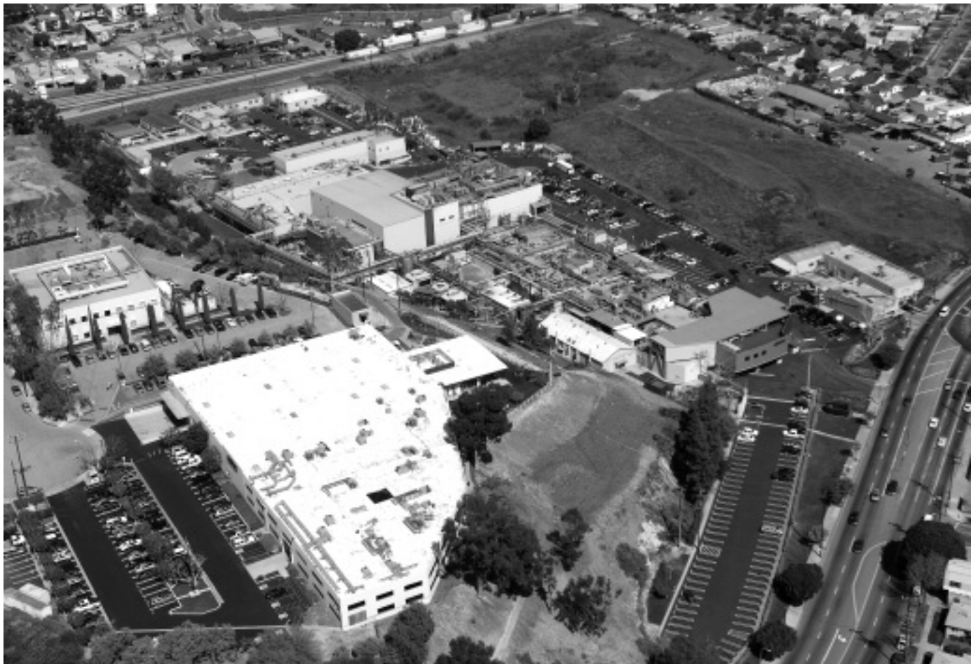
Complejo industrial de Clayton, Carolina del Norte.
