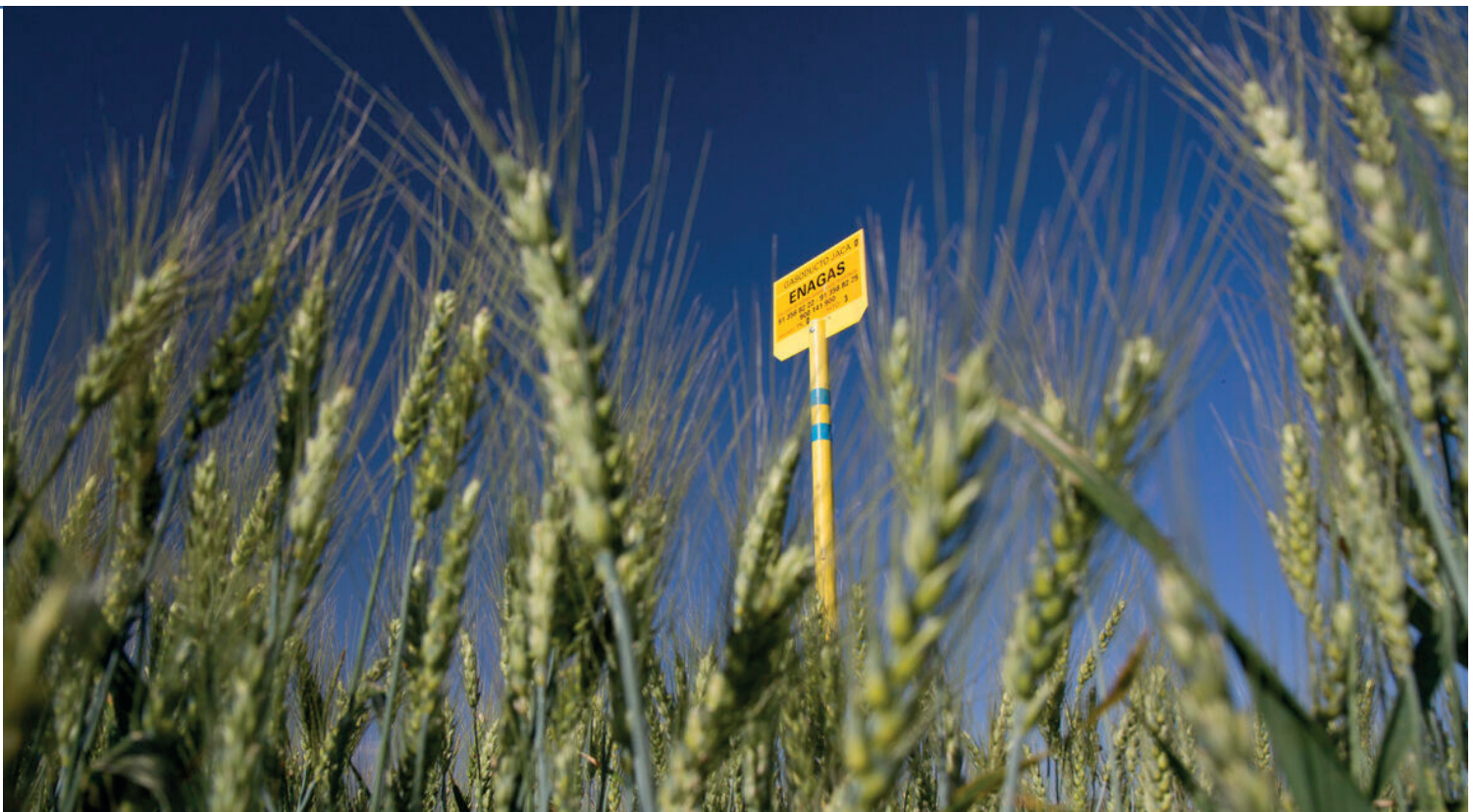
Hito que marca la presencia de un gasoducto subterráneo / Foto: Enagás
